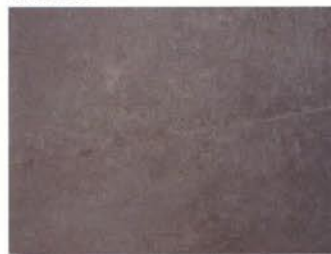
(添加コンクリート面)
