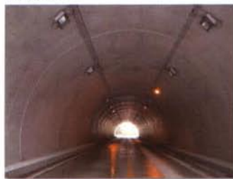
トンネル覆工
