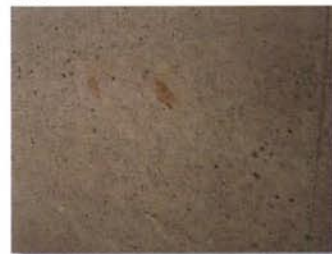
(未添加コンクリート面)
