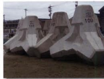
波消ブロック
