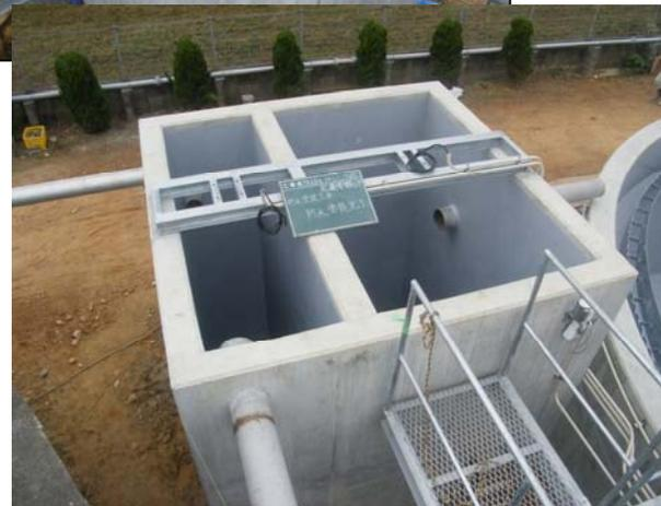
愛媛県大洲市 JAえひめに於いて、沈殿槽・凝集収反応槽の防水・防蝕工事を行いました。
