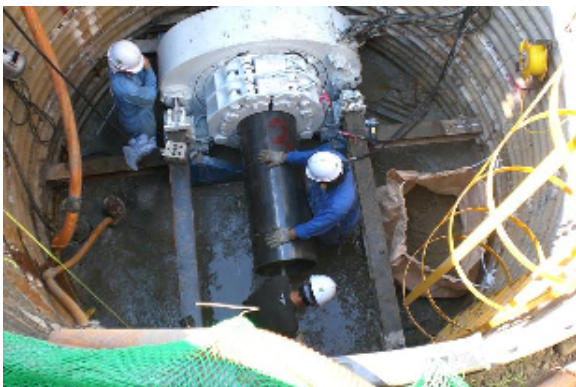
土砂排出状況
