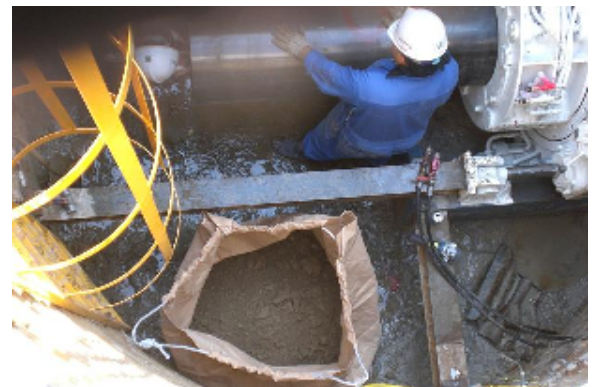
土砂排出状況
