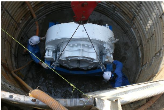
推進機吊降り据付作業状況
