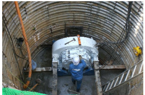
坑口・止水器取付作業状況
