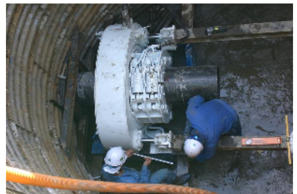
鋼管固定作業完了
