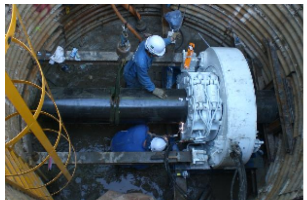
2本目鋼管吊り込みセット状況
