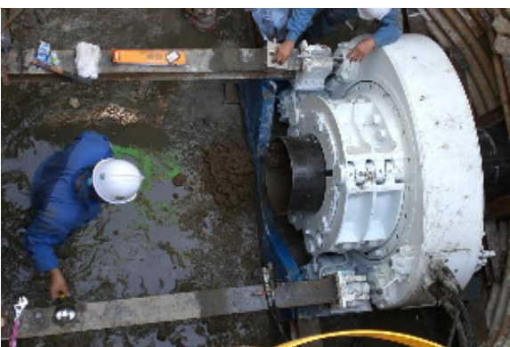
1本目推進完了状況
