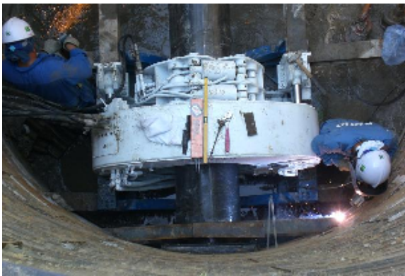
鋼管固定作業状況
