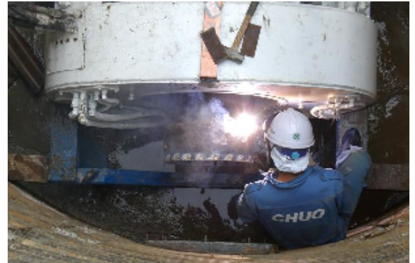
推進ビット取付作業状況
