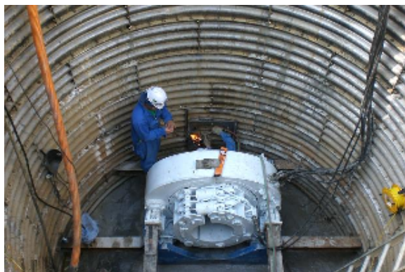
坑口・止水器取付作業状況
