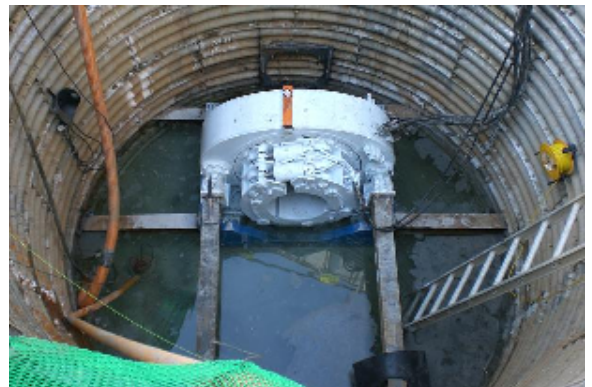
推進機固定作業完了
