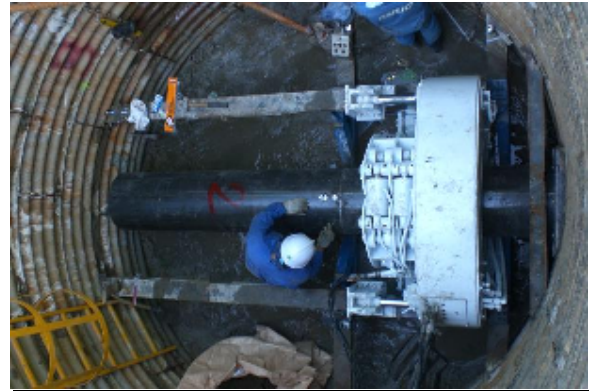
鋼管溶接作業完了
